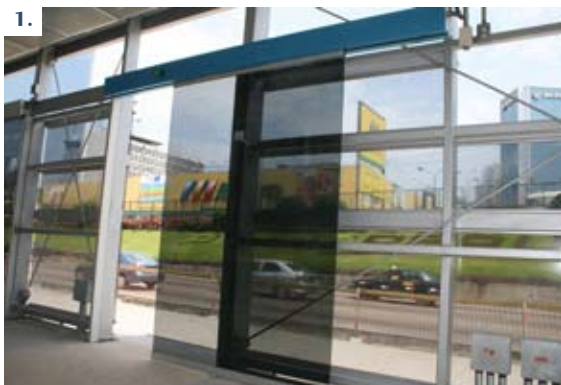
1. A través de un sistema de sensores las puertas de las estaciones del Metropolitano se abrirán de manera automática.
